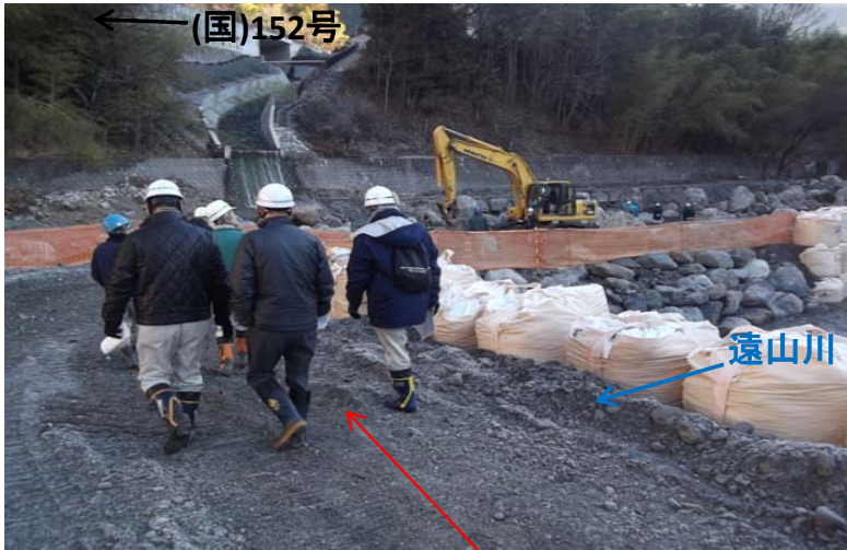
工事用進入路(遠山川横断)
