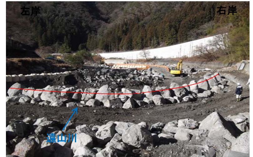
帯工形状(右岸側の半分) 上流より撮影
