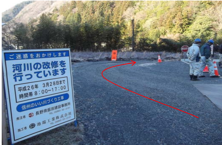
工事用進入路(消防団詰所付近)
