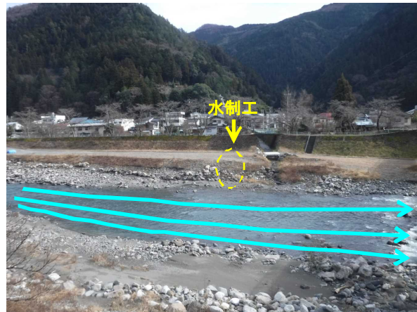
中橋上流の状況（水制工設置後） 平成28年12月
