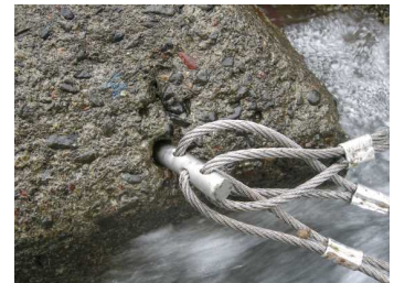
アンカーの様子（平成27年出水前）
