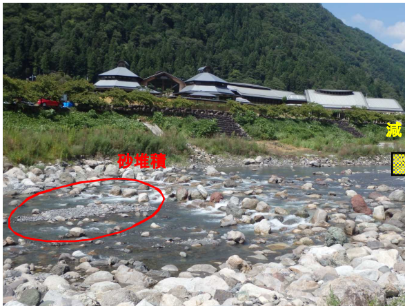
施設の状況（平成28年出水前）
