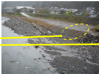
施設状況（平成27年11月）
