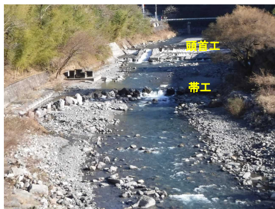
帯工上下流の状況（平成28年出水後）
