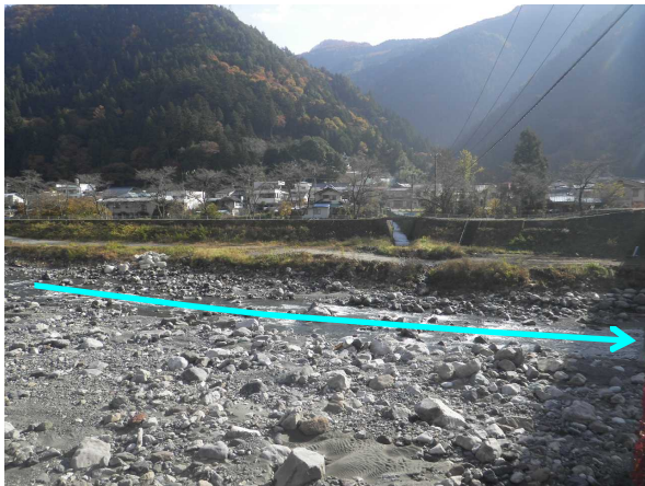
中橋上流の状況（水制工設置前） 平成26年11月
