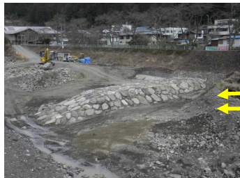
施設状況（平成27年3月）
