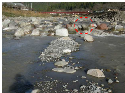
施設の状況（平成27年出水後）
