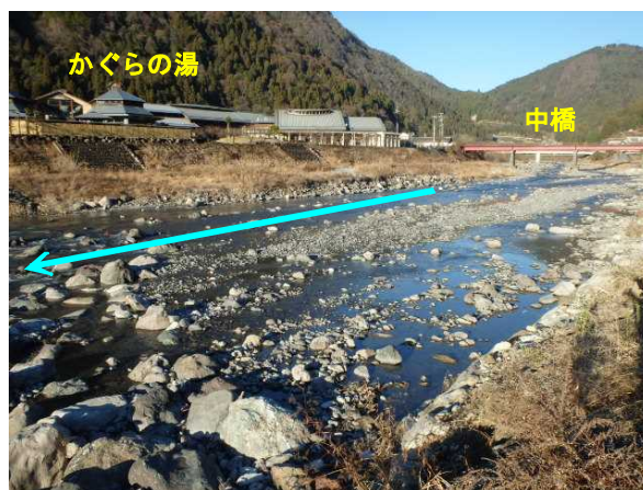
帯工から中橋の状況（平成28年出水後）
