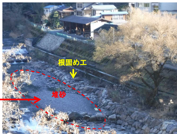
護岸の状況（平成28年12月）
