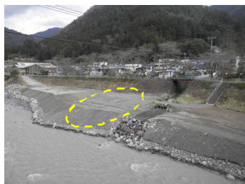
施設状況（平成27年3月）
