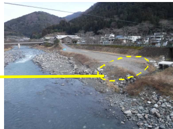
施設状況（平成28年12月）
