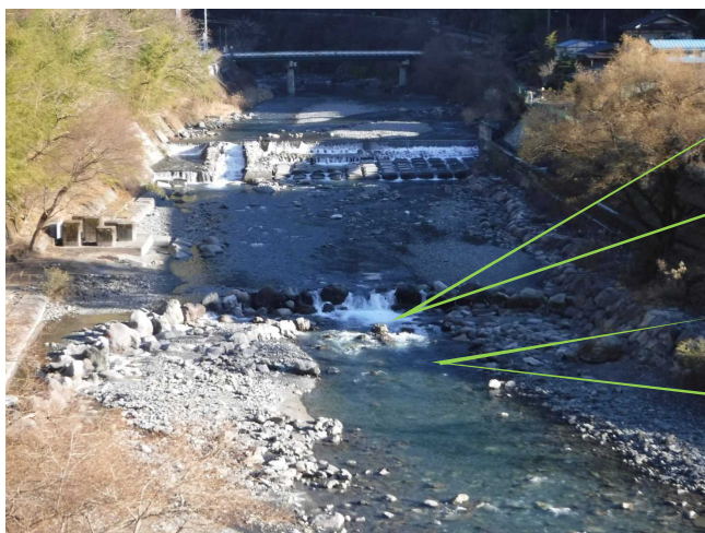
瀬と淵の状況（平成28年出水後）
