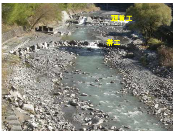
帯工上下流の状況（平成27年出水後）
