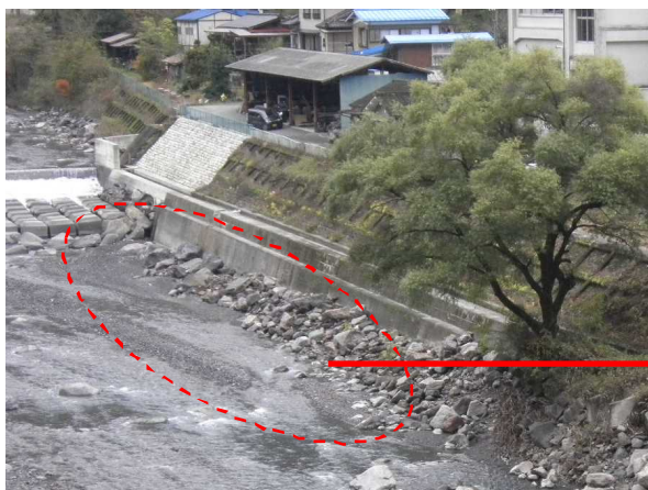
護岸の状況（平成25年11月）
