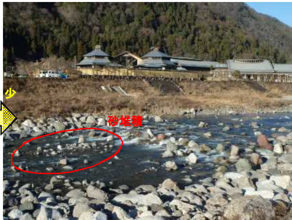
施設の状況（平成28年出水後）
