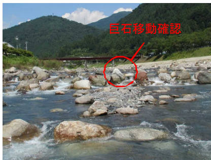
施設の状況（平成28年出水前）
