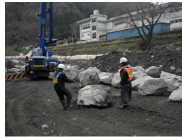
巨石の玉掛け作業。
