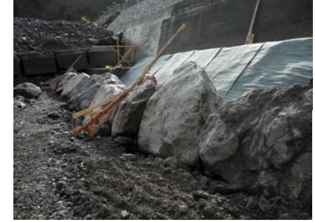
巨石φ1.5内外の根石据付け。
