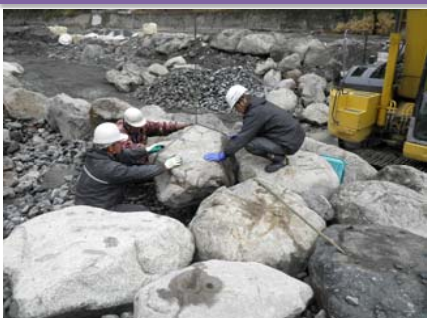
天端石据付け作業。
