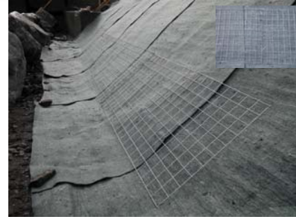
吸出し防止材と背面ネット取付け。
