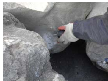
穿孔内部をブローアークリ粉除去作業。
