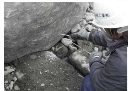
穿孔内部のくり粉除去作業。
