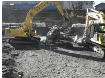
巨石(カ石)を据付。石材径は約φ3.0m。
