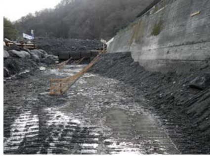
床付け後の丁張状況。
