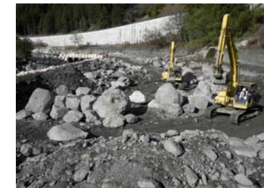
カ石の間隔は5.0m程度で据付け。
