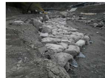
ワイヤーとアンカーで連結された床張工。
