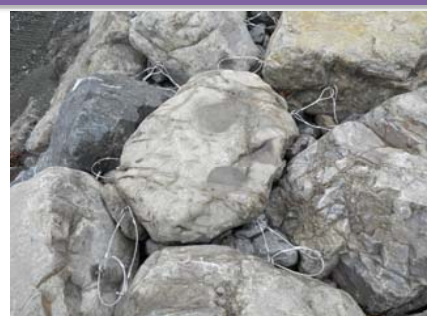
ワイヤーとアンカーで連結された天端石の状況。
