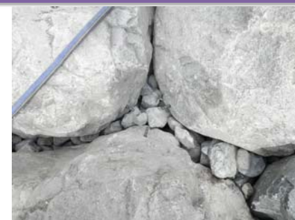
アンカー打ち込み状況 NTアンカーSUS製φ13mm L=90mm
