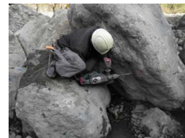
穿孔作業(ドリル径φ21.5mm・深さ80~85mm)
