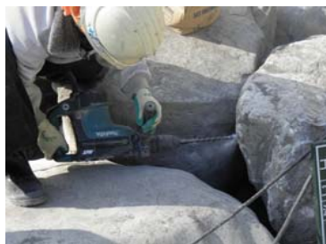
穿孔作業 (ドリル径φ14.5mm・深さ50mm)
