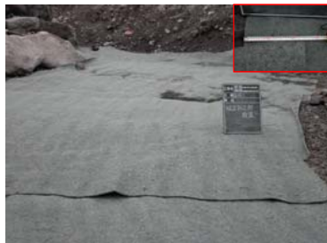
吸出し防止材を施工。 重ね10cm以上確保する。
