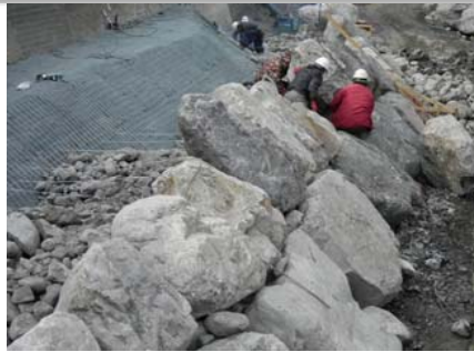
2段階目巨石据付け作業。
