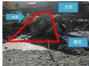
カ石を支える根石を2個据付け。石材径は約φ1.5m。 カ石は下流側に傾けて据付ける。
