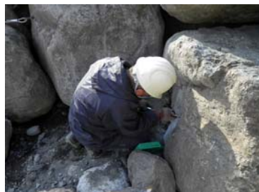
アンカーの打ち込み、ワイヤ-連結作業状況。
