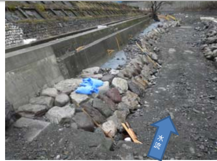
法面部石材据付け・天端石据付け径はφ1.5m内外。
