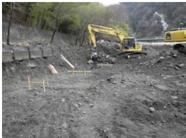
掘削・床付けを行い、丁張りを設置。
