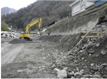
出入りを創出しての掘削作業。
