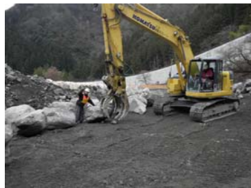
巨石の玉掛け作業。石材径はφ1.5内外。
