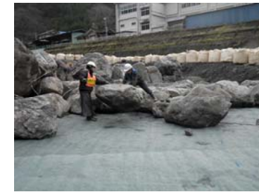
床張工巨石据付け作業。
