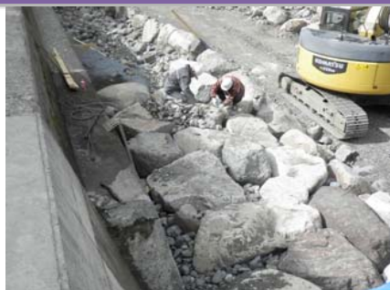
石材の隙間を栗石で詰める。
