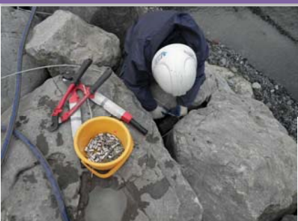
連結作業 (結束線SUSワイヤーφ5mm)
