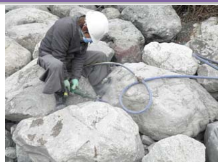
穿孔作業(ドリル径φ14.5mm・深さ50mm)
