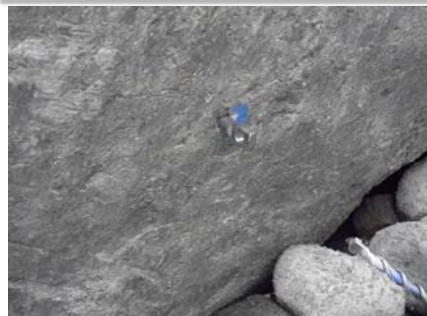
自在アンカー打ち込み。
