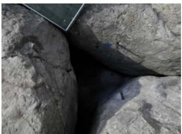
アンカーの打ち込み状況。
