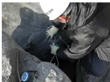
ワイヤー連結作業状況。
