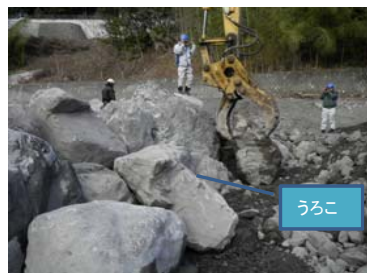
カ石や環石の上流側に「うろこ石」を据付けていく。
