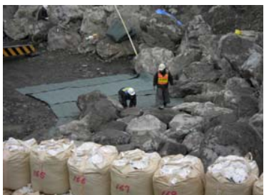
床張工巨石据付け作業。
