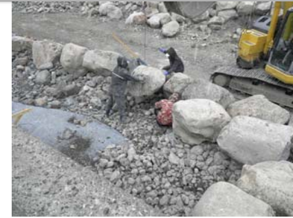
天端石据付け作業。
