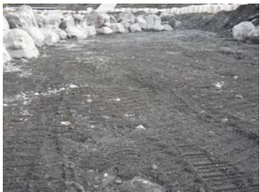
巨石帯工下流側「床張工」床付け。
