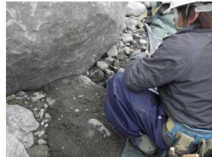
穿孔作業(ドリル径10.5mm・深さ30~40mm)
