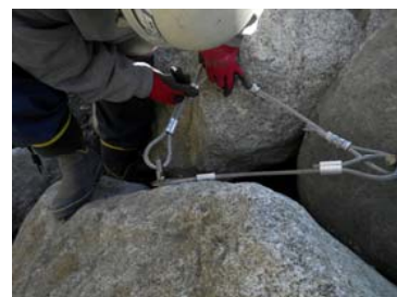
結束線SUSワイヤーφ9mm連結作業状況
