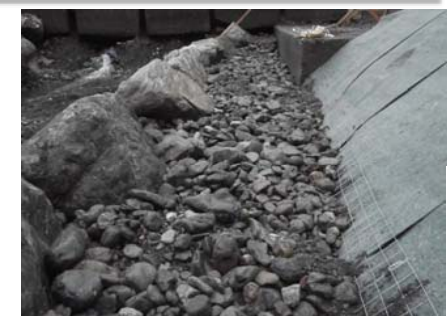
胴込材と裏込材を投入する。
