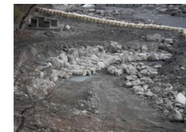
ワイヤーとアンカーで連結されたアーチ状の巨石帯工
