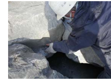
穿孔内部をブローでくり粉除去。
