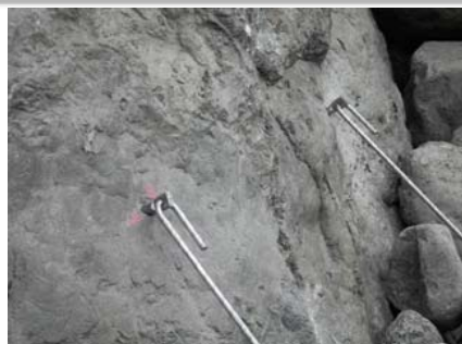
自在アンカーにアンカー側シャフト取付け。
