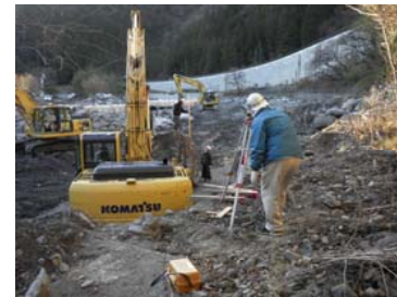
カ石の据付け高さの確認。
