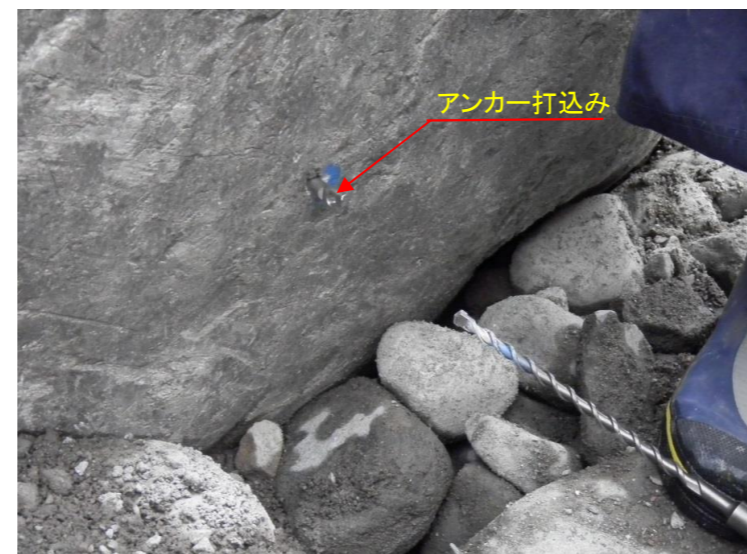
穿孔・アンカー打込み作業
