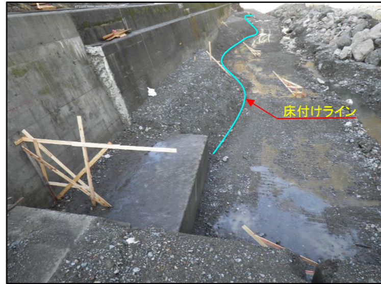
根固工(床付け) 上流より撮影
