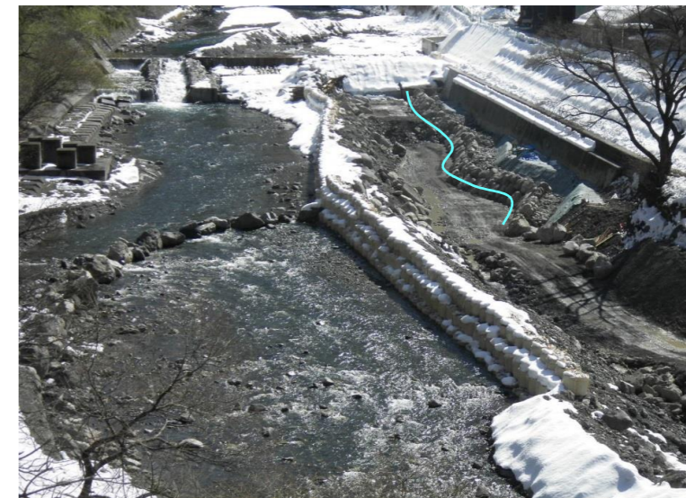
現場状況 (下流より撮影)
