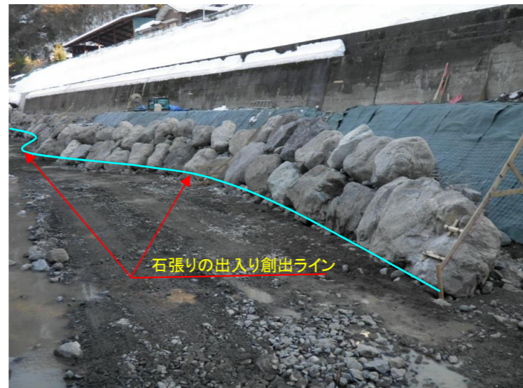
石張り施工状況(下流より撮影)
