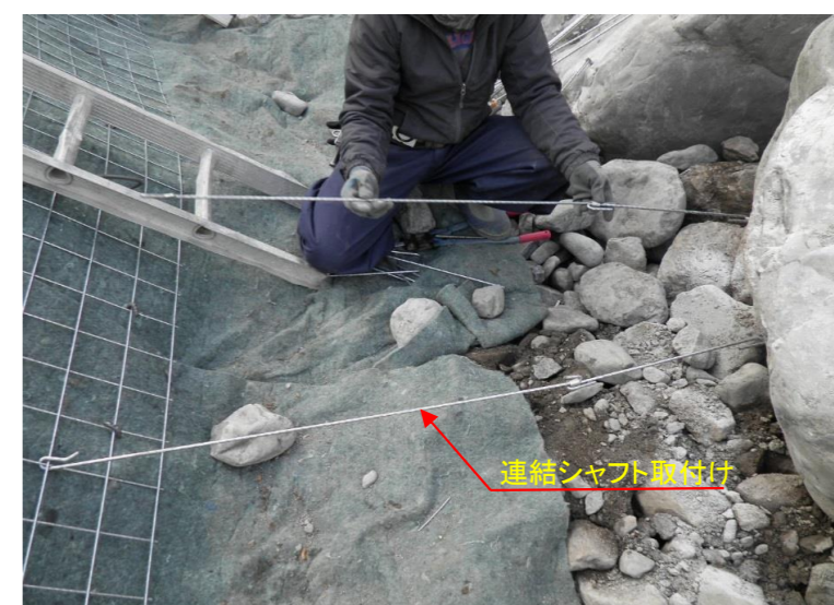
連結シャフト取付け作業
