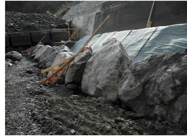
根固工石材据付け状況
