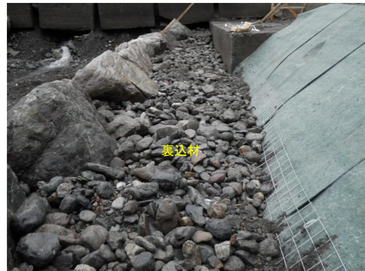
裏込材詰石状況
