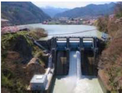
高遠ダム、高遠さくら発電所
