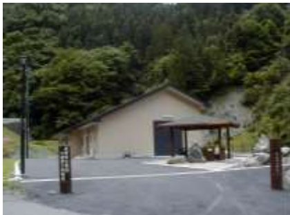
大鹿第2発電所
