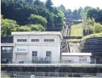
小渋第2発電所
