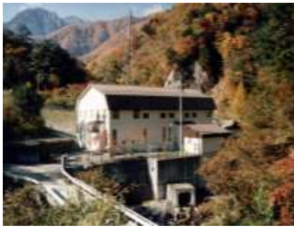
与田切発電所
