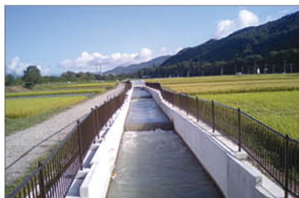
↑ 修理された水路の様子（大町市）
