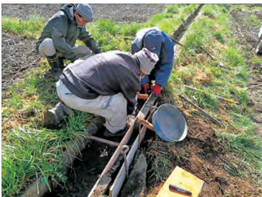
水路の補修 (箕輪町 長岡地区)
