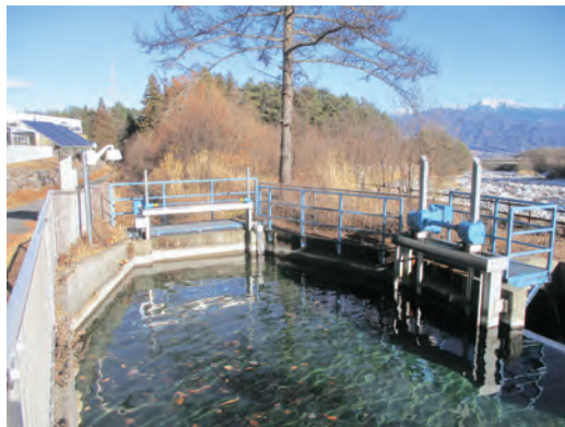
自動化・遠隔化された丸山井水門 (宮田村)
