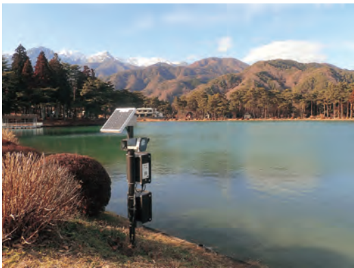
対策工事及び監視システムが設置されたため池 (飯島町 千人塚ため池)
