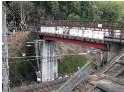
耐震工事を実施する上越野跨線橋 (南木曽町)
