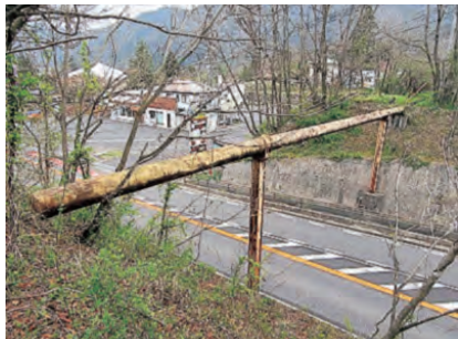
耐震工事を実施する野又水管橋 (木曽町)
