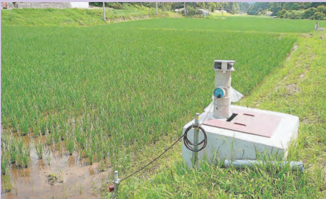
二重地区の自動給水栓
