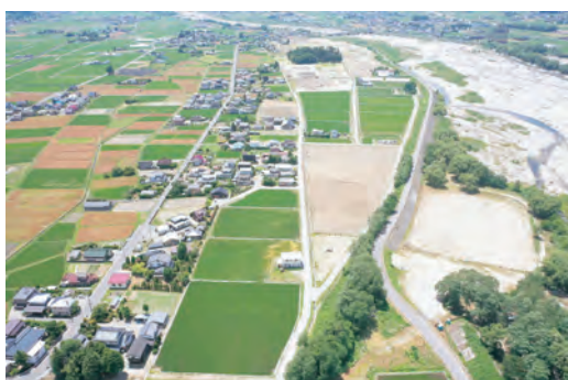
経営体育成基盤整備事業会染西部地区（池田町）
