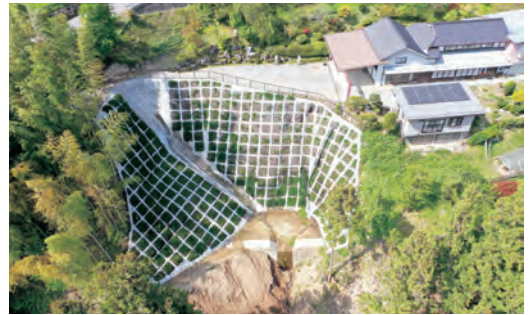
簡易吹付法枠工による地すべり対策 (阿南町)
