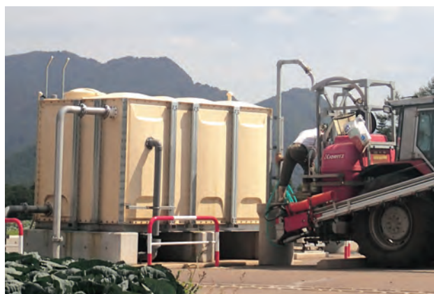
効率的で安定した用水確保のため、井戸を増設し貯水槽を整備
