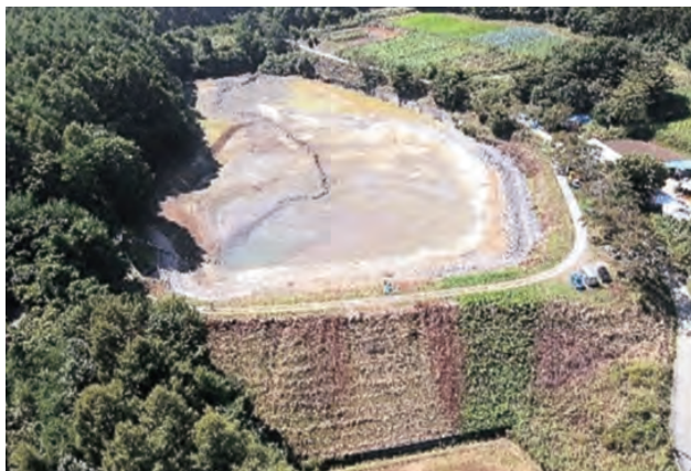
堤長 150 m に及ぶ防災重点農業用ため池（佐口ため池）
