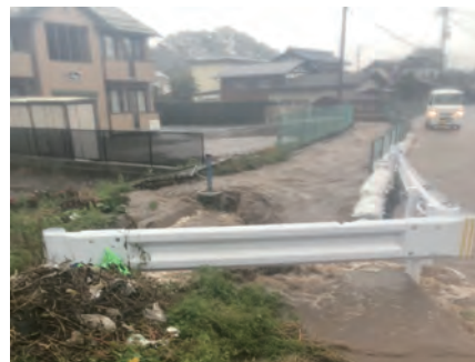
突発的な大雨による農業用水路の溢水
