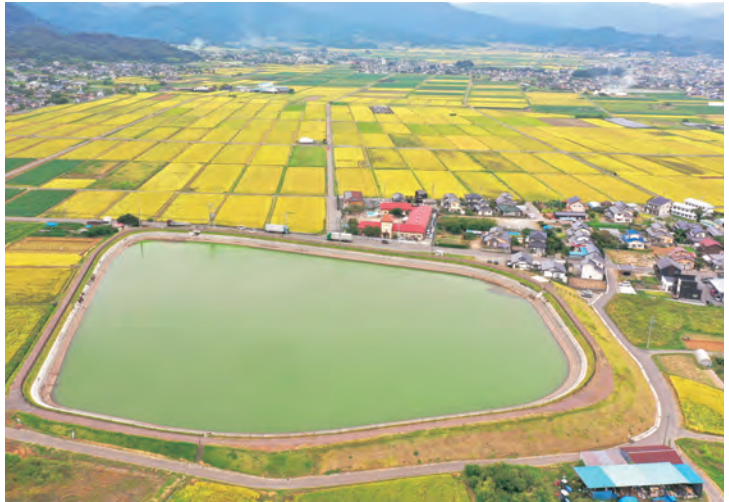
耐震化工事が完了した下之郷新池（上田市）
