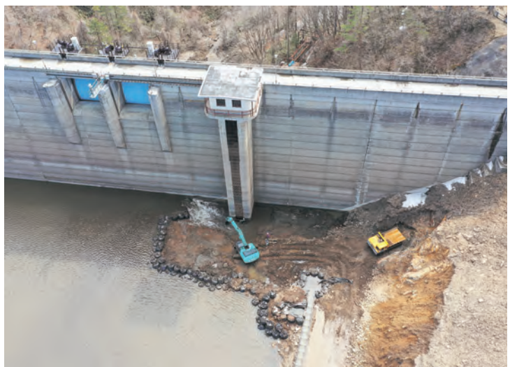
県営かんがい排水事業菅平地区では、菅平ダムの老朽化した取水ゲートの更新工事を行っています。
