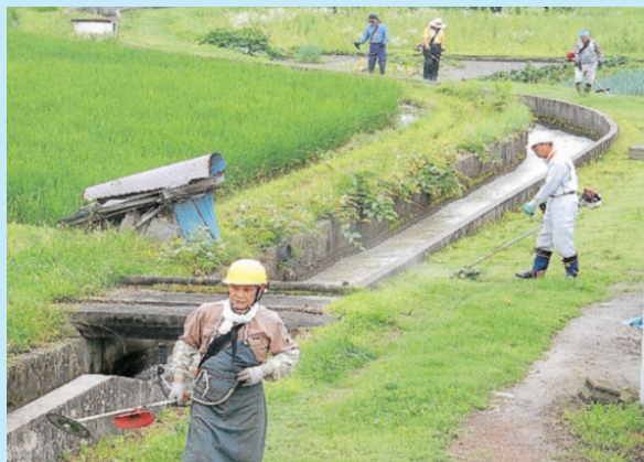
水路周りの草刈り
