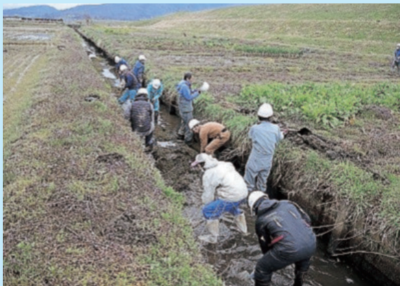
水路の泥上げ
