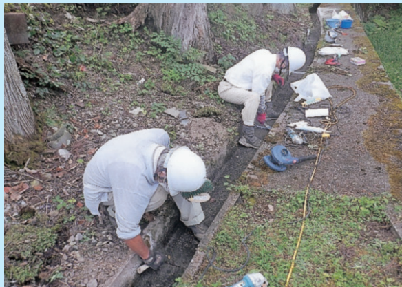
用水路の目地補修
