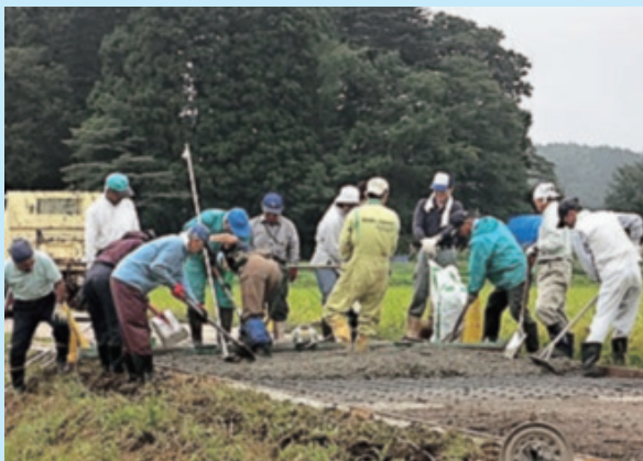
農道のコンクリート舗装
