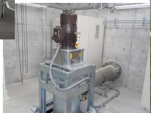
水車設置状況 (スクリーウ水車)
