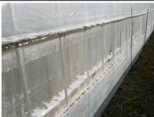
【O】ハウス開口部への防虫ネットの設置
