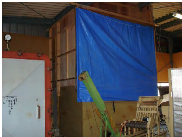
【〇】 ミキサー（かくはん機）の粉塵対策の実施
