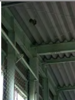
【○】防鳥ネットの設置
