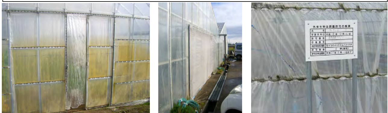
【〇】栽培施設の開口部をネットで被覆
