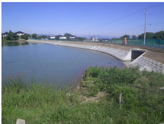
【耐震対策が完了したため池】
