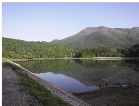
【工事が完了した浅川大池】
