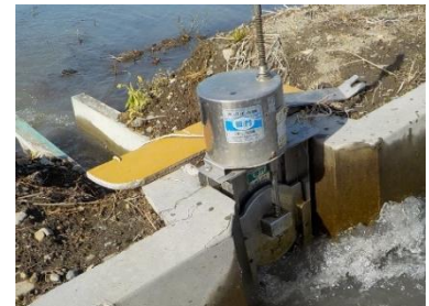
【水田への給水を自動停止する水門】
