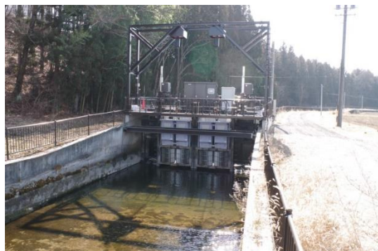
【梓川右岸幹線の落差を活用した小水力発電（松本市）】
