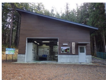
【吉野小水力発電所外観】
