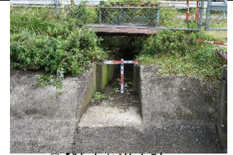
①【狭小な洪水吐 田子池（長野市）】
