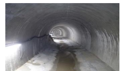
【水路トンネルの補修・補強】
