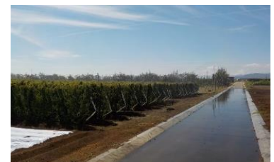
【水路兼用農道の整備】
