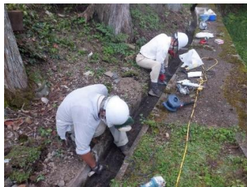
水路の目地補修
