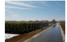
【水路兼用農道の整備】
