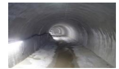
【水路トンネルの補強】
