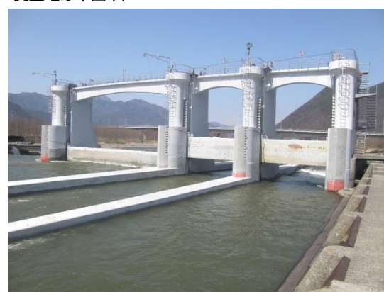
【表面被覆により劣化の進行を抑制】
