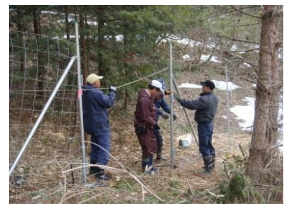
【集落住民による侵入防止柵の設置】
