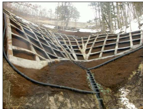
【法枠工等の整備により地すべりを未然に防止】 (地すべり対策事業 長岩地区)
