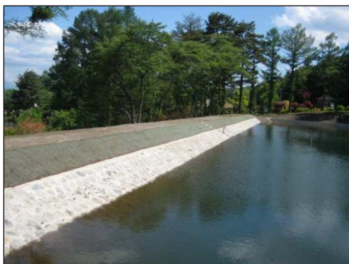
【堤体の改修により安全性が向上したため池】 (県営ため池等整備事業 駒ヶ根地区)
