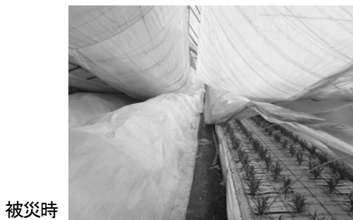
【平成26年2月大雪のパイプハウス被害及び復旧状況】
