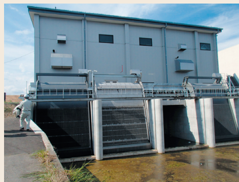
【整備が完了した排水機場：相之島排水機場（須坂市）】
