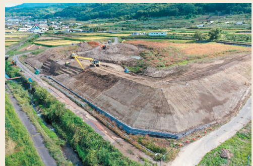
【ため池堤体の改修：吉田池（上田市）】
