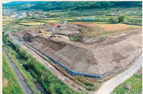
【ため池堤体の改修：吉田池（上田市）】
