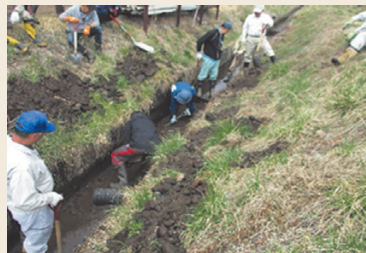
【水路の泥上げ】
