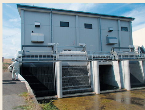
【整備が完了した排水機場：相之島排水機場（須坂市）】
