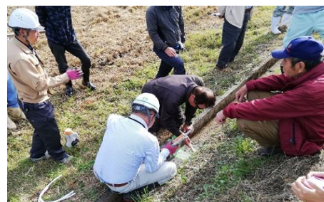
【技術研修会（水路の目地補修）】
