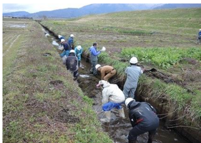
【地域住民の参加による水路の泥上げ】
