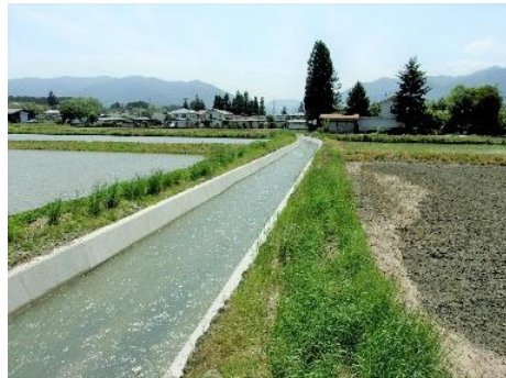
【工事が完了した新村堰】
