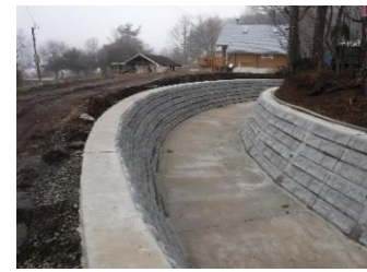
【滝之湯堰の改修状況】
