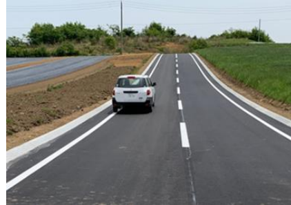
【幅員を広げて舗装した農道】
