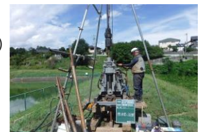
【ため池の耐震性診断】
