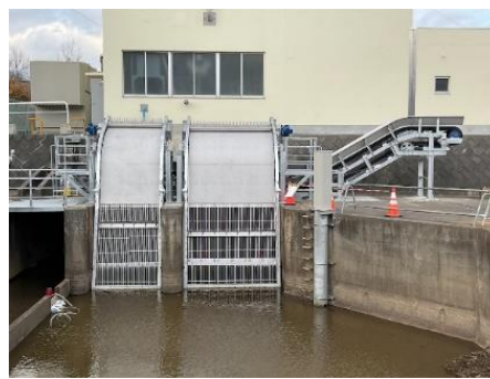
【排水機場の改修】 （長野市：清野排水機場）
