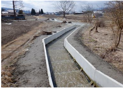
【更新した水路】
