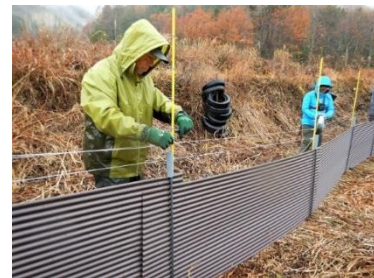
【電気トタン複合柵の設置】
