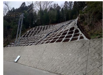
【地すべり対策工事 生坂村】
