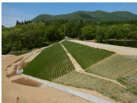
【防災重点農業用ため池の耐震化】 （中野市：大池）
