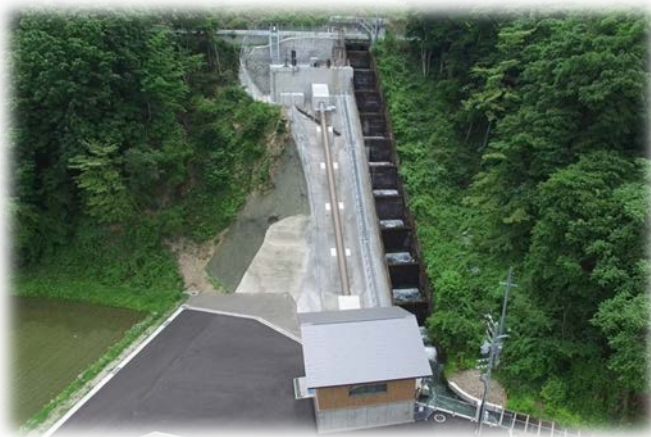
【県営かんがい排水事業】 春富6号地区 小水力発電施設
