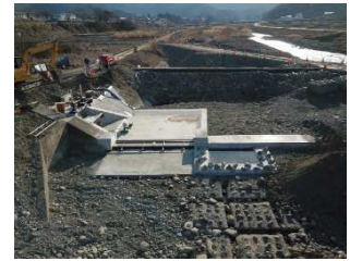
【鎖川地区（頭首工改修）】
