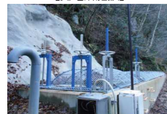
【沈砂池及びヘッドタンク】
