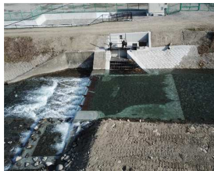
【頭首工改修後】
