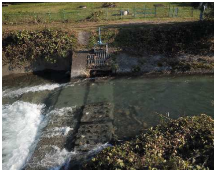
【頭首工改修前】
