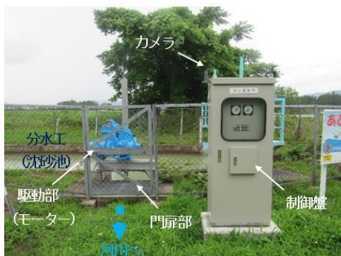
【行人塚 分水工排水門】
