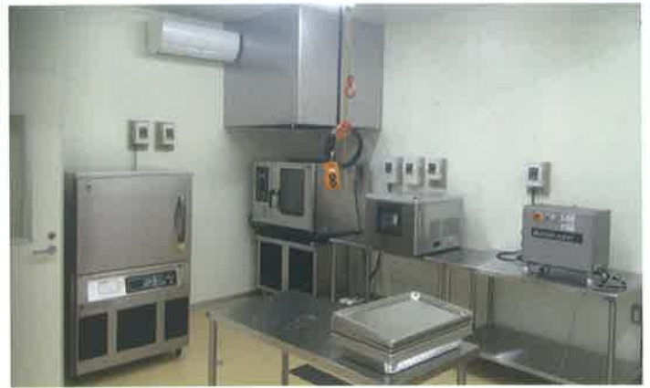
小諸市野生鳥獣商品化施設(二次処理室)
