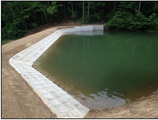
【堤体・洪水吐の改修により安全性が向上したため池】 県営農村地域防災減災事業 牛鹿宇山地区（立科町）
