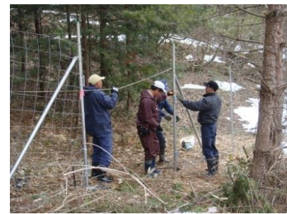
【集落住民による侵入防止柵の設置】
