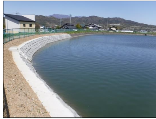
【堤体の改修により安全性が向上したため池】 県営農村地域防災減災事業 西塩田地区（上田市）
