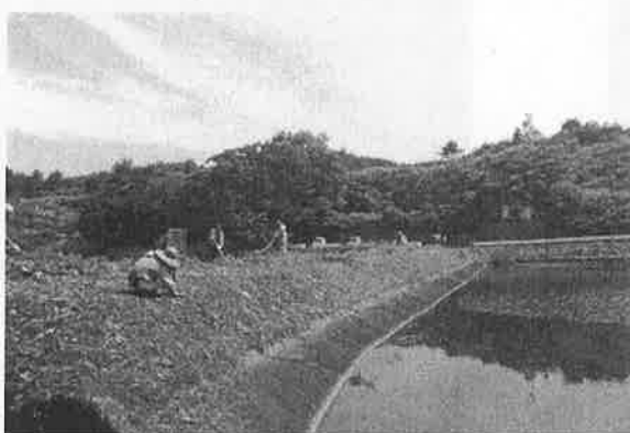
【地域ぐるみで行うため池堤体の草刈り】
