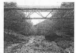
【老朽化した用水路】
