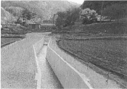
【整備が完了した用排水路】
