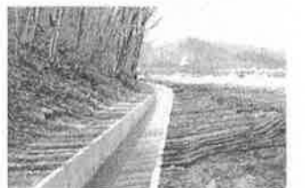
【春富6号地区水路改修後】
