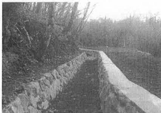
【改修工事が完了した大河原堰】
