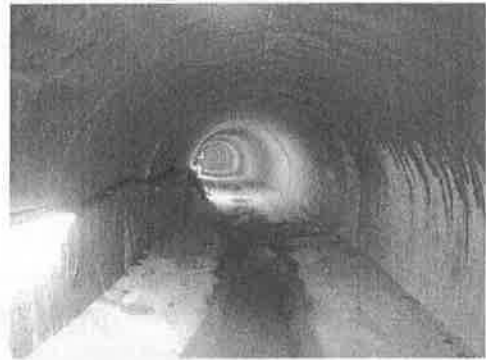
【機能回復した水路トンネル】
