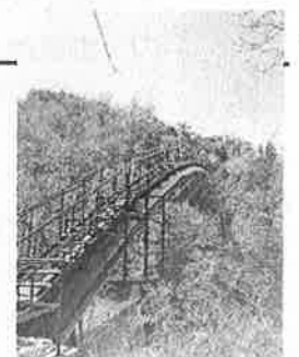
【竜東一貫水路(蛇川サイフォン)】
