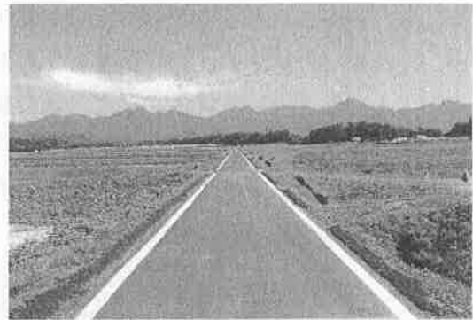
【幅員を広げて舗装した農道】
