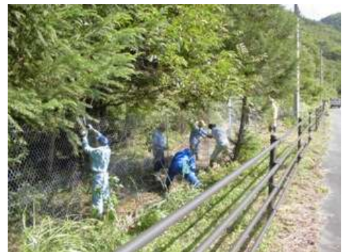
【集落住民による侵入防止柵の共同設置作業】
