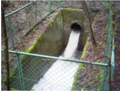
【農業用水を利用した小水力発電(上松町)】
