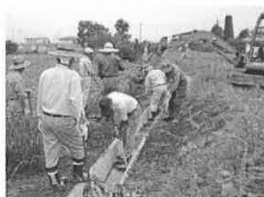
【水路の泥上げ】
