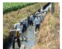
水路の泥上げ
