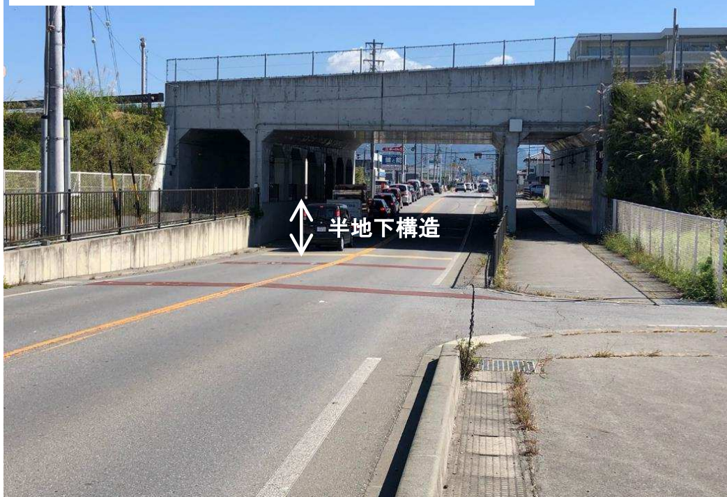
中部横断自動車道
