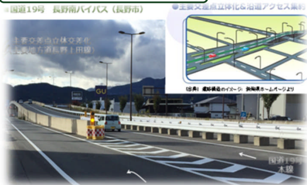
長野環状道路（国道19号等）
