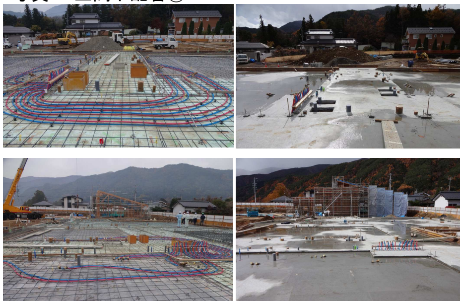
写真 土間下配管①
