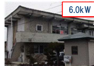
小川区公会堂（民間施設）
