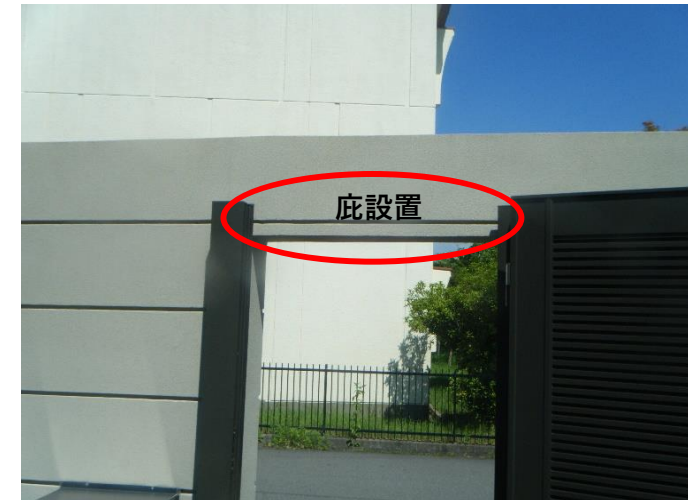
④通用口（宿舎側から）
