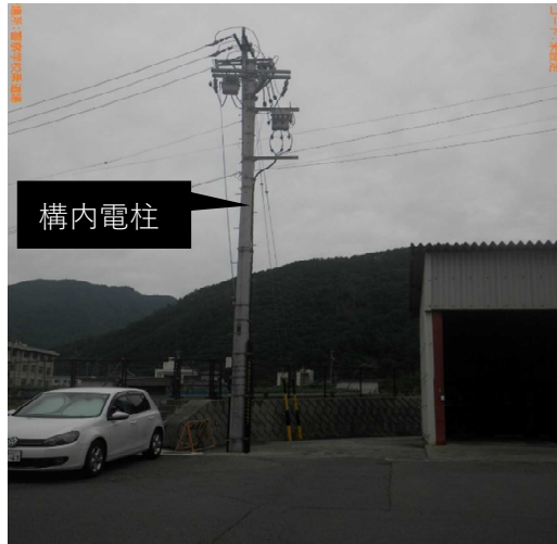
③SOG開閉器（第1柱安全装置・ブレーカー）
