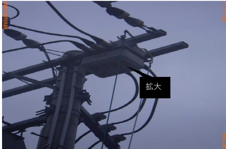
③SOG開閉器（第1柱安全装置・ブレーカー）
