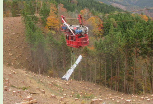
架線による防護柵運搬
