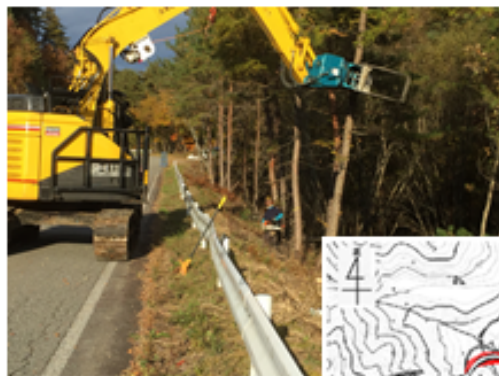
法面の支障木伐採
