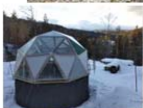
パネルを設置して 越冬、耐雪試験も実施
