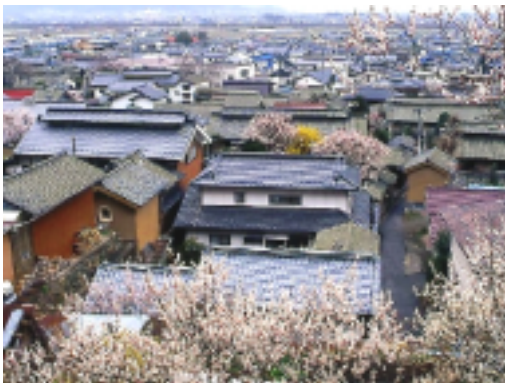
塩尻地区の町並み
