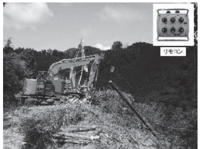
写真-4 スイングヤーダ集材
