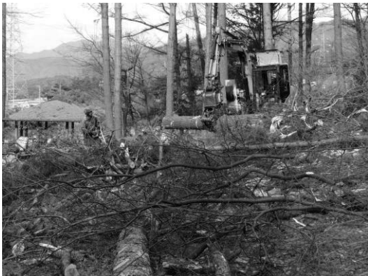
写真-3 伐採作業
