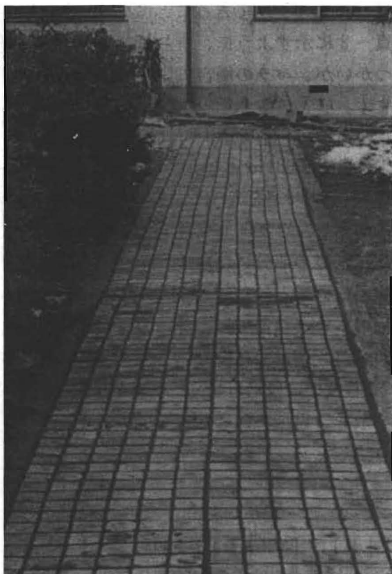
＜カラマツ間伐材を利用した 木レンガ歩道＞
