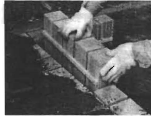
写真-2 木レンガ歩道の施工
