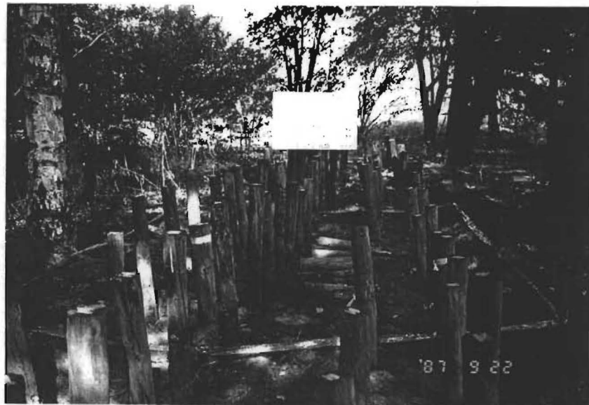
写真-1 設置したアカマツ、カラマツ防腐処理杭の状況 すでに倒れている杭もある。
