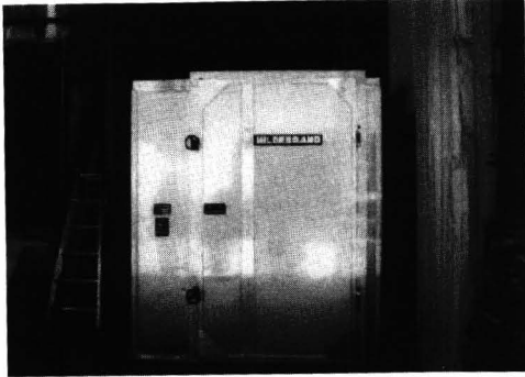
写真-3 乾燥機の設置
