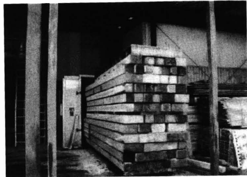
写真-4 乾燥機の設置(材の積込後)
